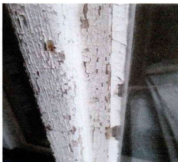
poškození vnějšího rámu
