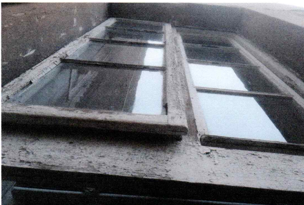
Poškození venkovních křídel, poškození venkovních ráků
