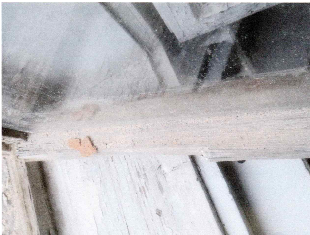
Poškození okapnice, chybějící tmel, chybějící barva
