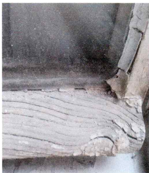
Poškozená okapnička, chybějící tmel
