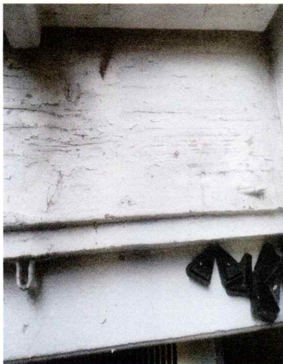
poškození špaletové desky
