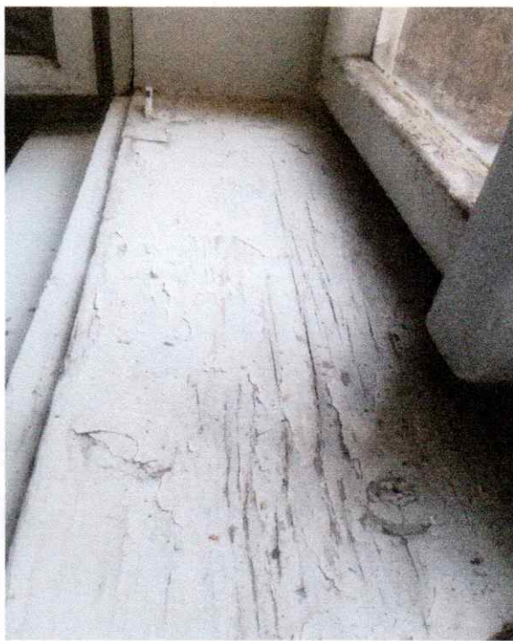
poškození špaletové desky, poškození křídla
