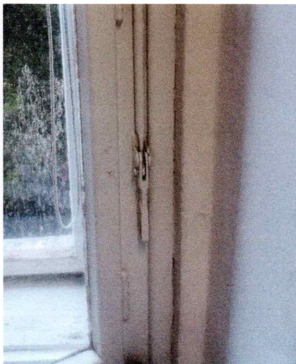
pákový mechanismus, profilace křídla, lištování
